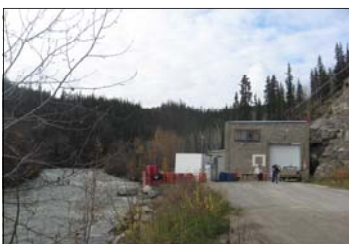
Existing Mayo plant
